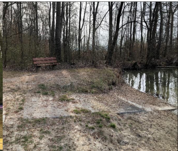
Photo 7 : Rampe de mise à l'eau actuelle
