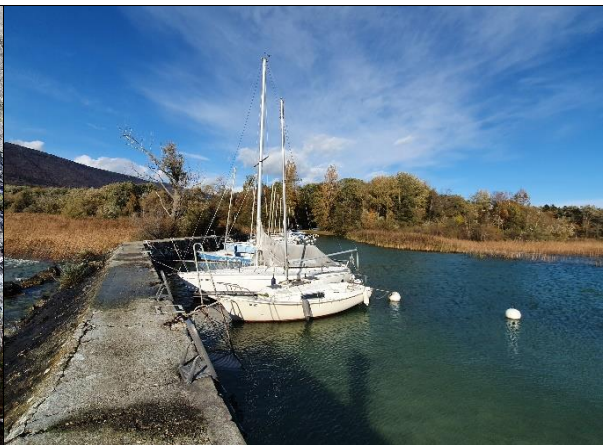
Photo 2 : Revêtement au mortier dans la partie ouest
