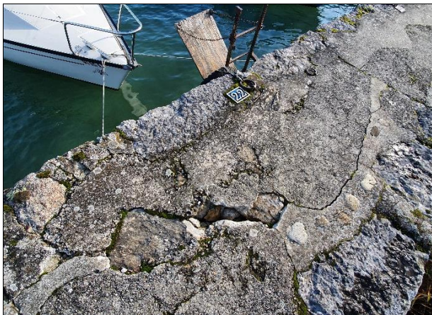
Photo 1 : État de surface du môle sur la première partie
