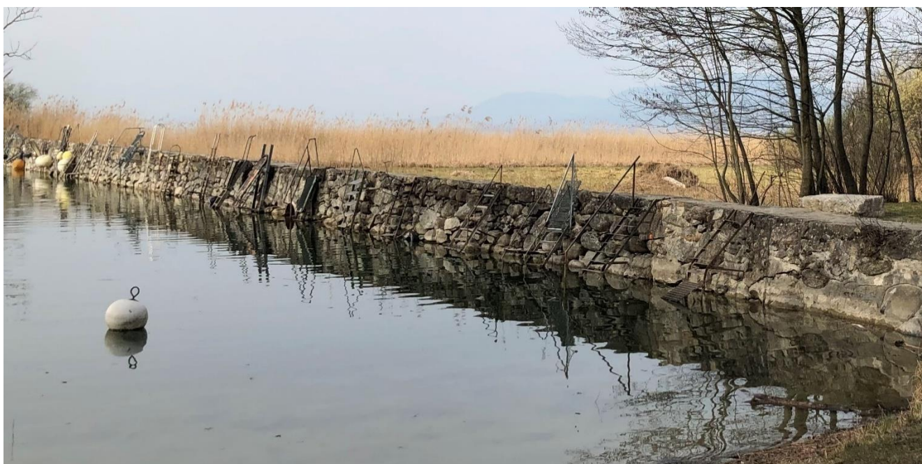
Photo 5 : Vue générale des échelles et escaliers réalisés par les locataires des places
