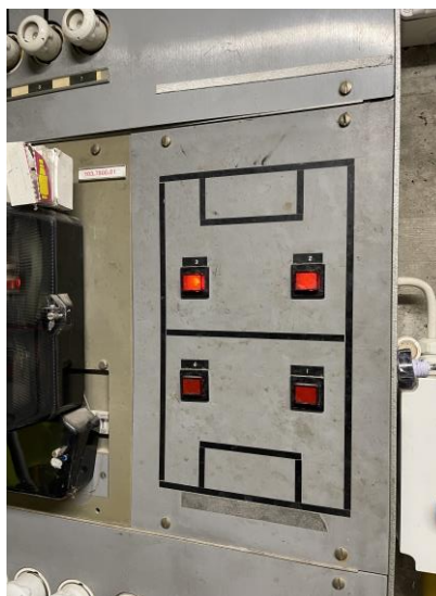
Boutons poussoirs d'allumage séparés par mât
