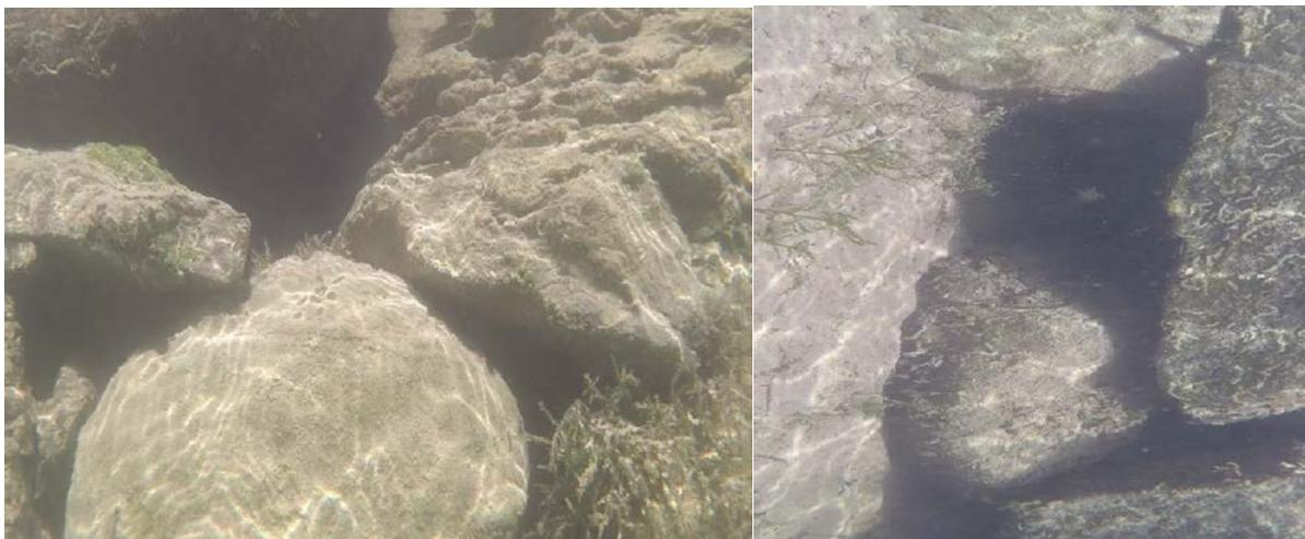
Ces cavités permettent le passage du sable fin côté roselière dans le port, créant un tassement local (côté roselière) très dangereux pour la stabilité générale de l'entier de l'ouvrage. Par conséquent, si ce tassement n'est pas maîtrisé, il peut provoquer un renversement (basculement) et donc l'effondrement de la digue.
