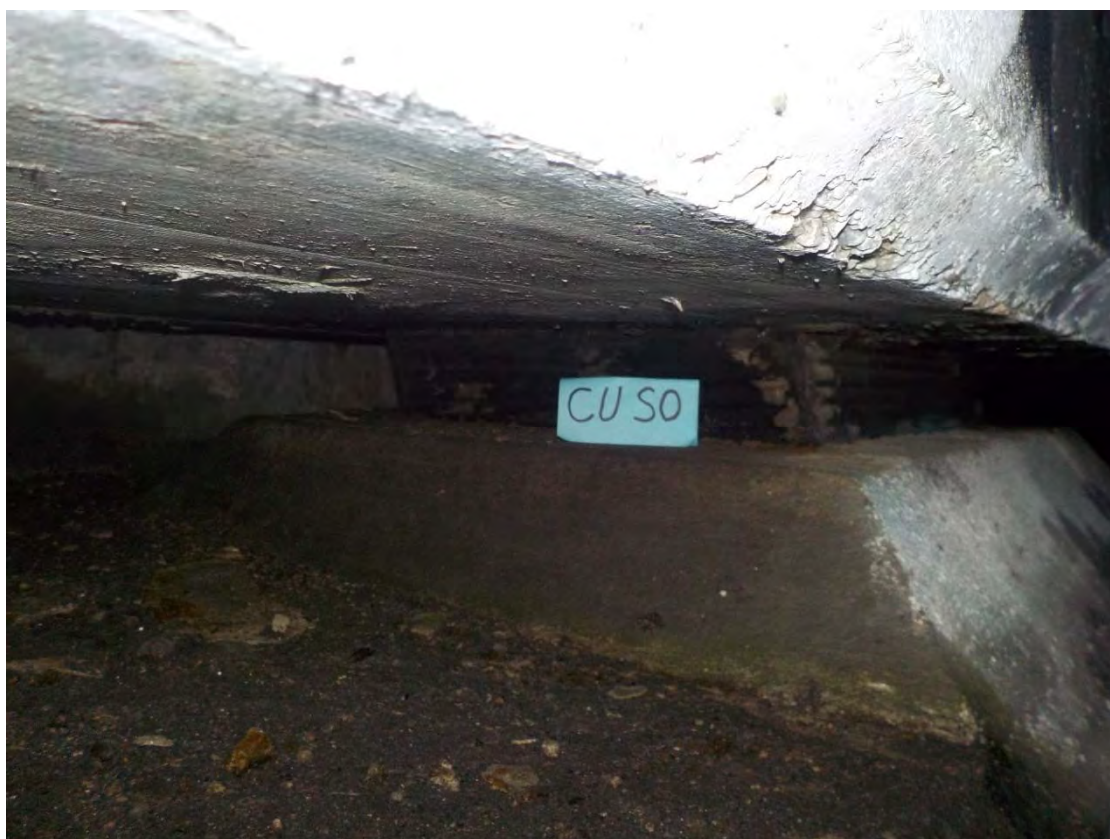
(Photo 2 : Culée Sud / Appui 11)
