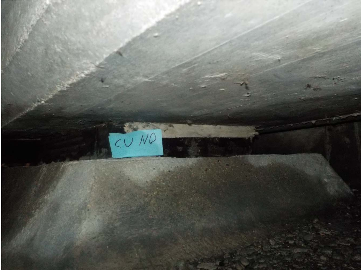
Pile 2 : Appui n°5 (Pile 2 Est 2 : AP PI E2)
