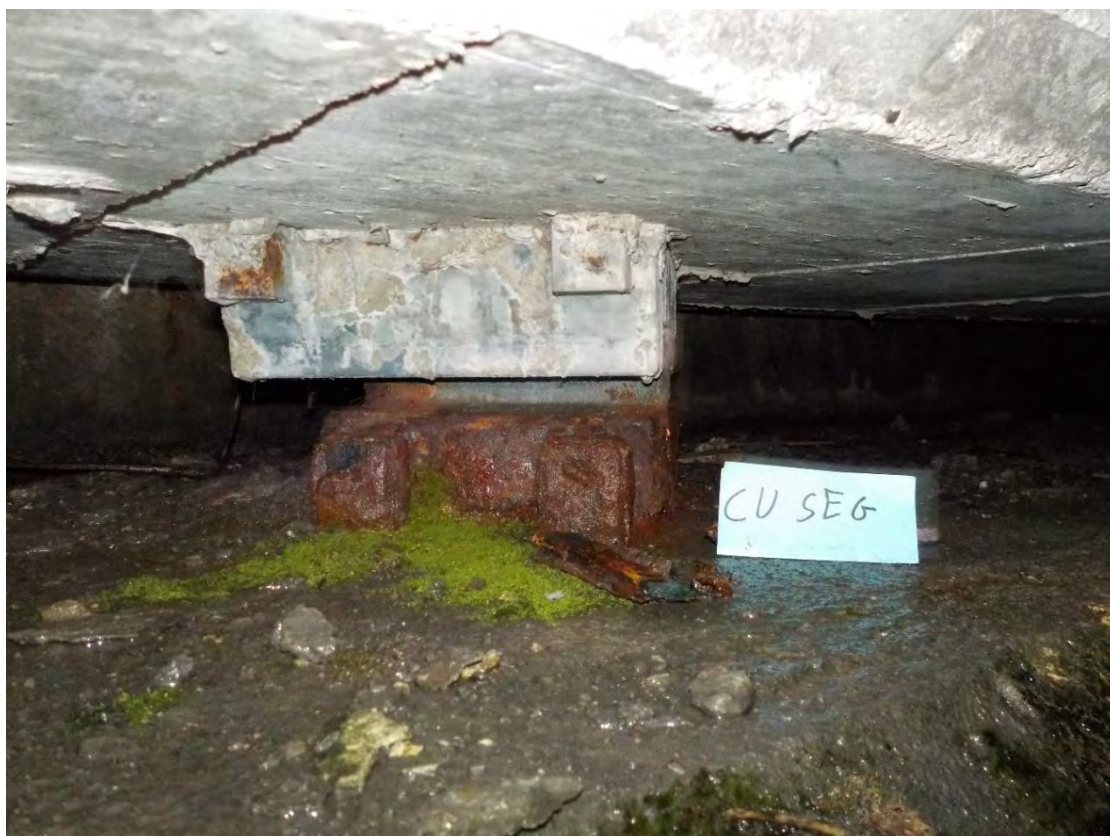
(Photo 3 : Culée Sud/ Appui 10)
