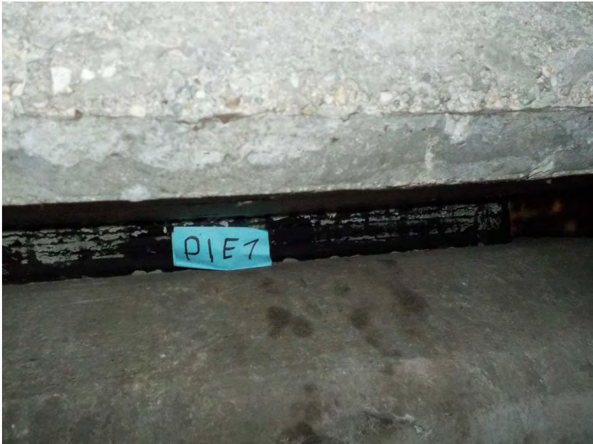
Pile 1 : Appui n°7 (Pile 1 Est 1 : AP PI E1)
