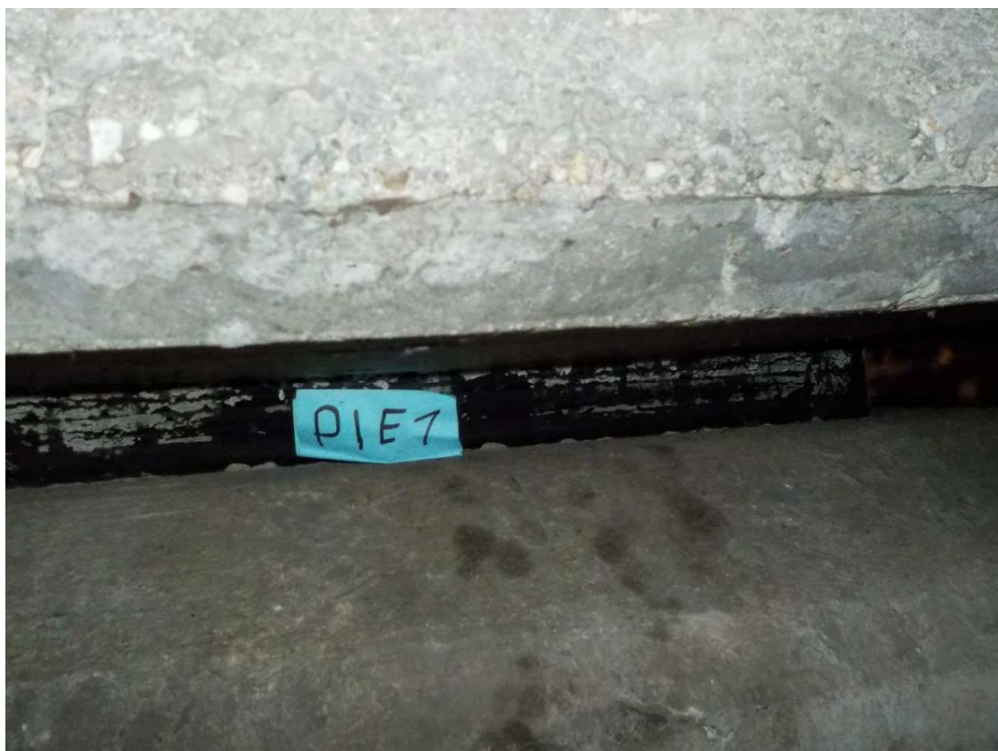
(Photo 1 : Pile 1 / Appui 7)
