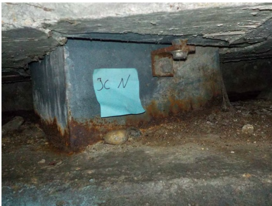
(Photo 4 : Culée Nord / Appui 3)
