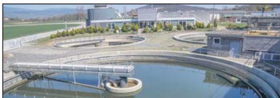
STEP (Station d'épuration des eaux) d'Epagnier, du Syndicat intercommunal de la Châtellenie de Thielle.
