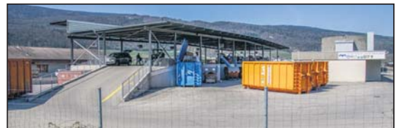
Déchetterie de l'Entre-deux-Lacs à Cornaux, du Syndicat intercommunal de la Châtellenie de Thielle.
