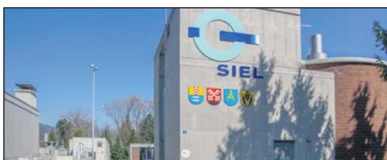
STEP du Syndicat d'épuration des eaux SIEL, au Landeron. Photos: Jean-Albert Nyfeler
