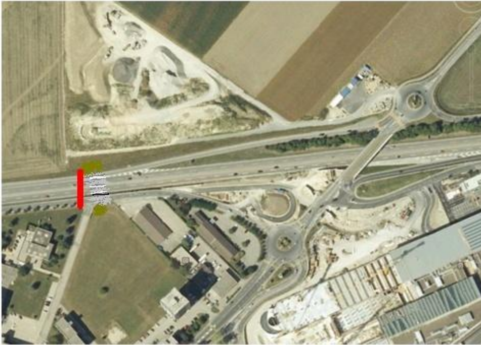
Figure 2 : situation générale et emplacement de la passerelle
