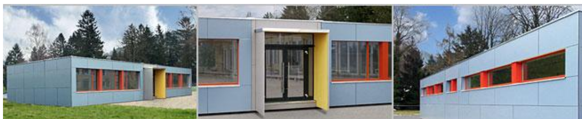
Figure 2 : construction modulaire provisoire de type ERNE
