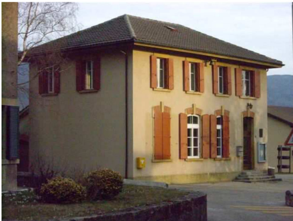
Vue 1 : façades Sud – Ouest
