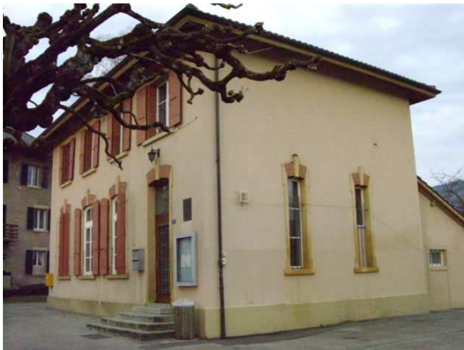
Vue 2 : façades Sud – Est
