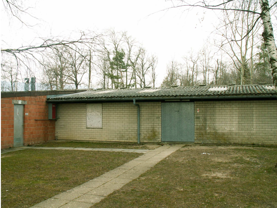
Vue 1 : façade Sud – côté camping des résidents
