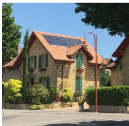
Exemple d'installation solaire photovoltaïque parfaitement intégrée sur un bâtiment protégé
